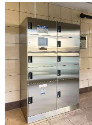
宅配ロッカー
