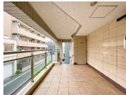
共用エントランス
