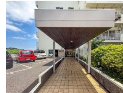
共用エントランス
