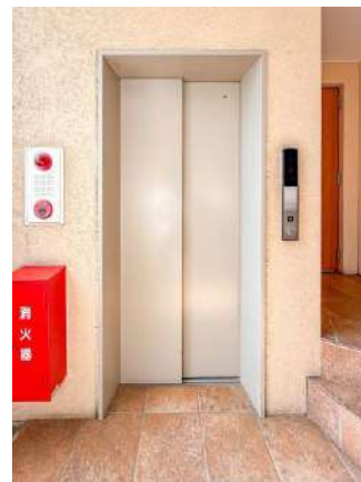
エレベーター
