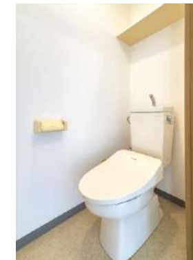
トイレ(※温水洗浄便座)
