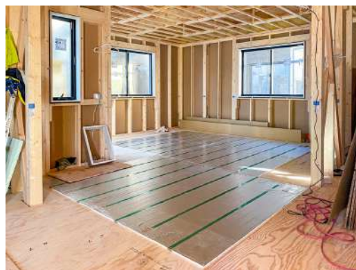
現地施工時の画像。
