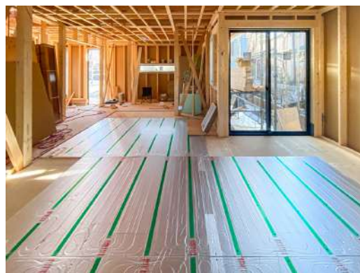
現地施工時の画像。
