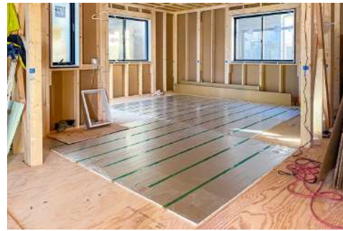
リビング床暖房(施工画像)
