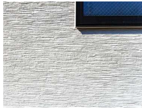
外壁(サイディング)
