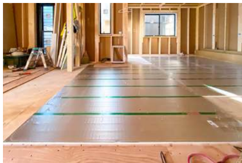
リビング床暖房(施工画像)
