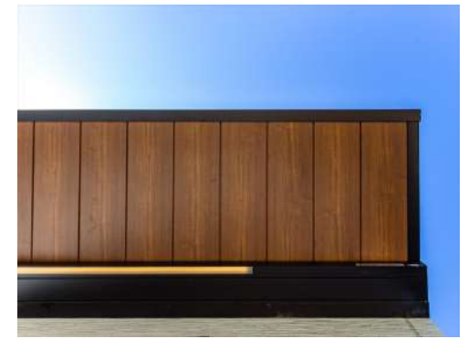
玄関前庇:木目調(LED照明付き)
