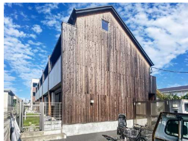
外壁杉板貼り (一部)
