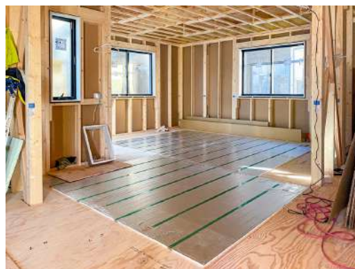
現地施工時の画像。
