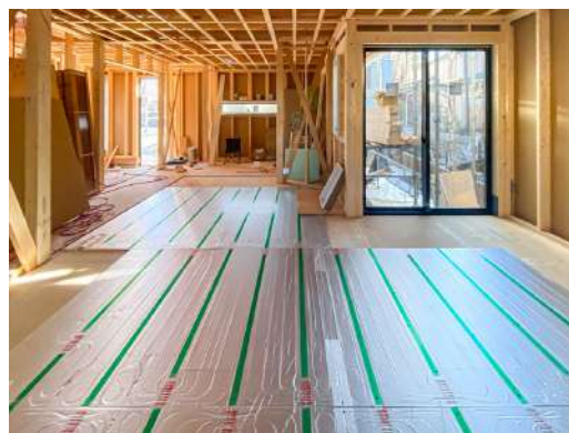
現地施工時の画像。
