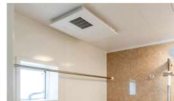
■換気 換気暖房乾燥機 (100V) ヒカルリモコン (メタル調) なし
